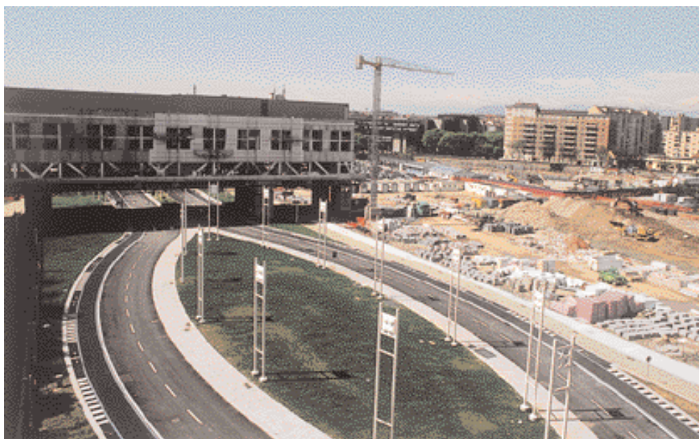
Sopra, vista del cantiere e dell'area dei lotti successivi. Sotto, il sistema sospeso per le lavorazioni in quota.
